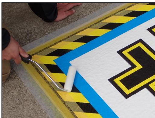
写真. 砂目下地に対してフィルムを収める方法
