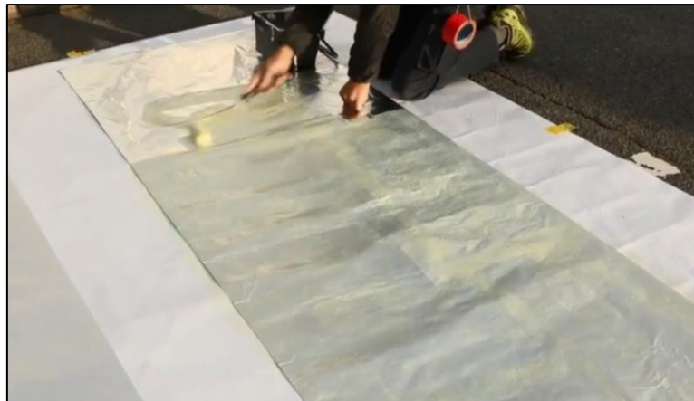
写真. フィルム裏面への専用接着剤の塗布
