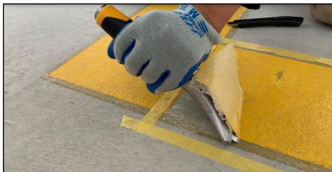
写真. スクレーパーによるフィルム剥離外観
