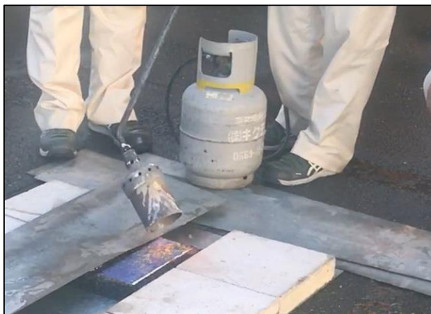
写真. プロパンガスバーナーによるフィルム剥離外観
