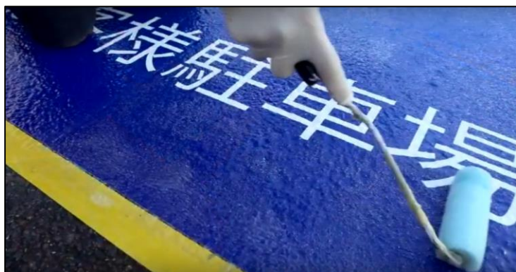
写真．主剤と硬化剤の混練およびフィルム上へのオーバーコート剤塗布
