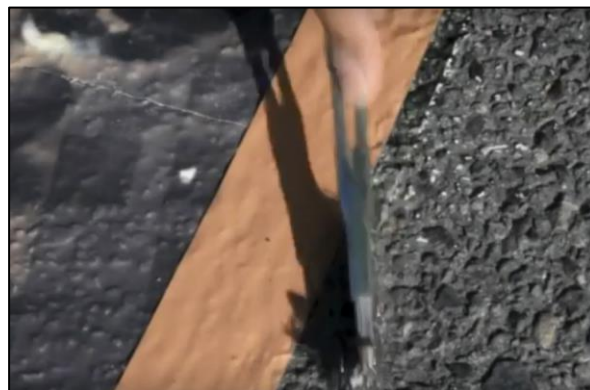
写真. 下地へのフィルム貼付およびはみ出した接着剤の除去
