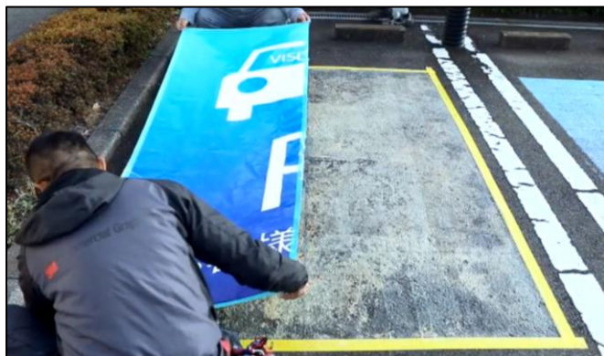
写真. 下地へのフィルム貼付およびはみ出した接着剤の除去
