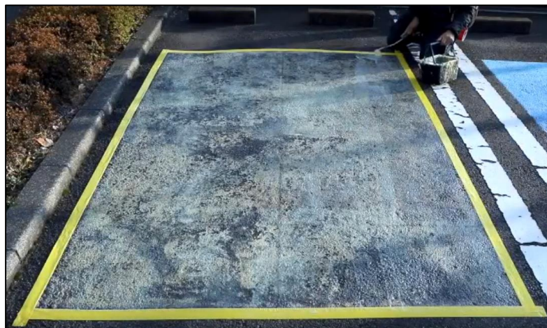
写真. 下地への専用接着剤の塗布
