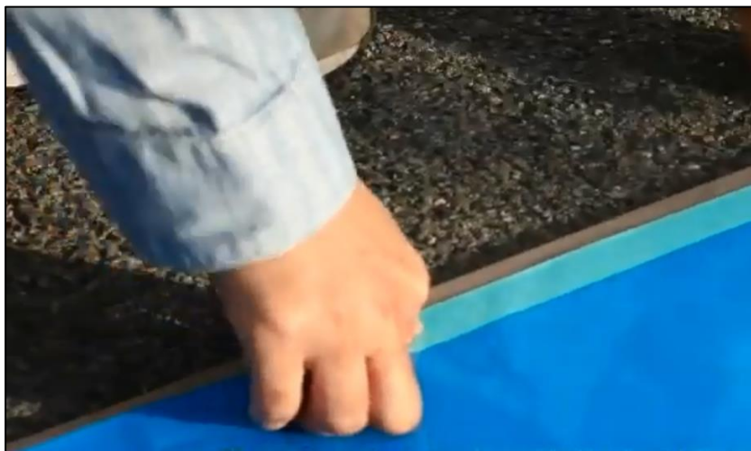
写真．フィルム表面へのマスキング処理
