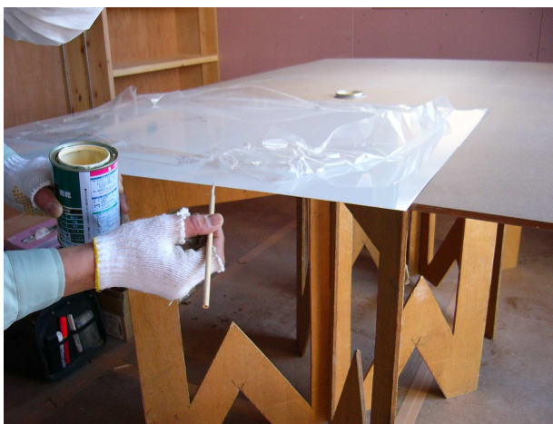
(錆止め塗料塗布)端部全てに塗ります
