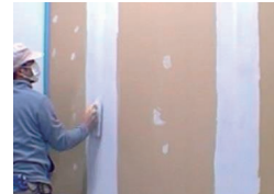
▲シーラー処理欠点例 (液だれ)
