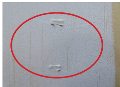
下パテ処理後 (上パテ時均す)
