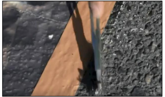
写真 6 下地へのフィルム貼付およびはみ出した接着剤の除去
