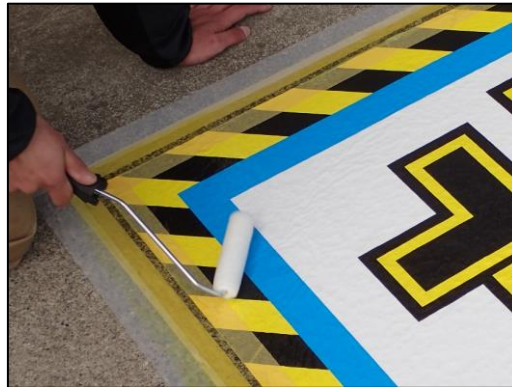
写真 7 砂目下地に対してフィルムを収める方法
