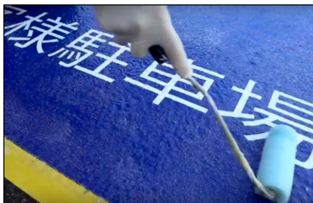
写真9 主剤と硬化剤の混練およびフィルム上へのオーバーコート剤塗布
