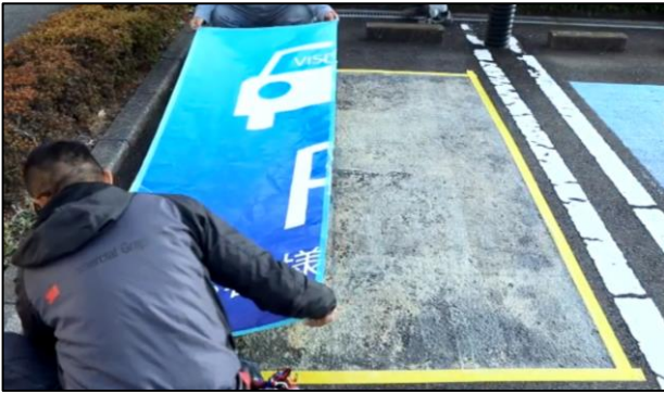
写真 6 下地へのフィルム貼付およびはみ出した接着剤の除去
