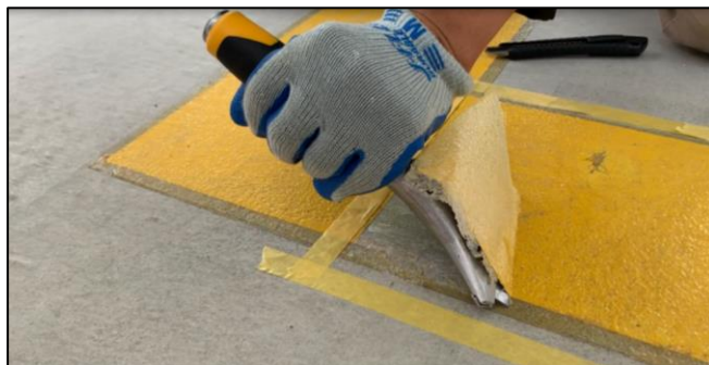
写真 12. スクレーパーによるフィルム剥離
