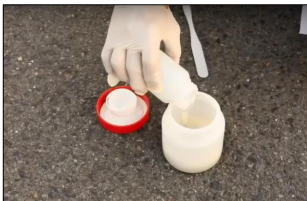
写真9 主剤と硬化剤の混練およびフィルム上へのオーバーコート剤塗布
