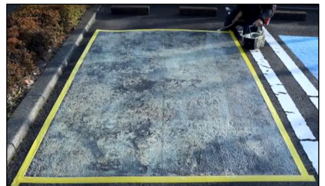
写真 5 下地への専用接着剤の塗布
