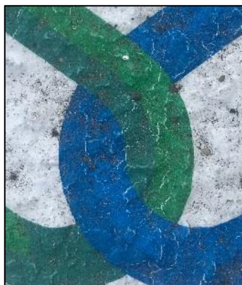
写真 15 下地の流動性に伴うフィルムのひび割れ
