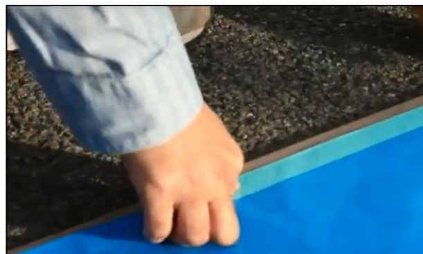
写真2 フィルム表面へのマスキング処理
