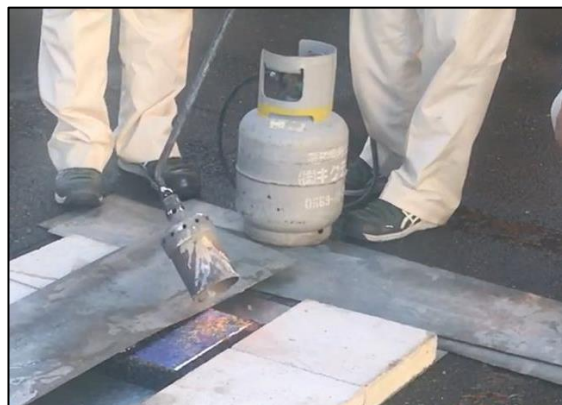
写真13 プロパンガスによるフィルム剥離
