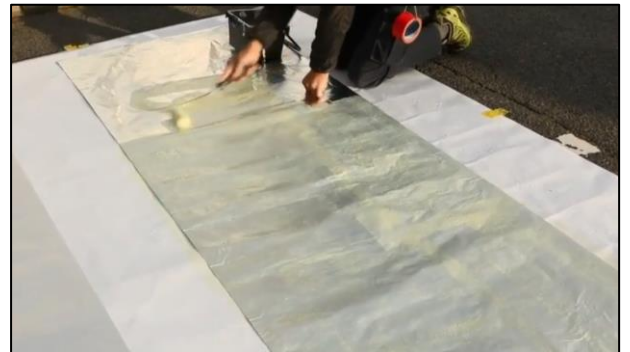
写真 4 フィルム裏面への専用接着剤の塗布
